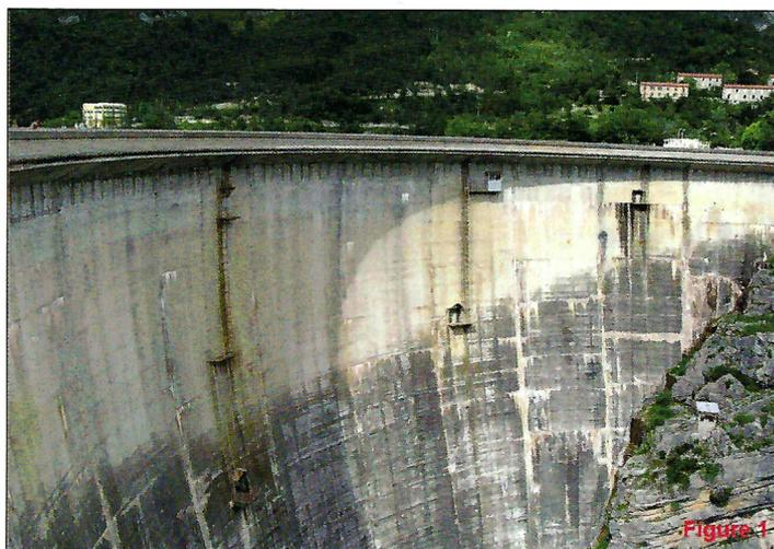
Fig. 1 - Une vue partielle du barrage avant nettoyage et modification. On discerne bien l'ombre de la corniche sur le barrage.
