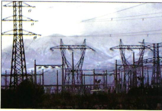
Avant 1960 les trains fonctionnent, en France, en courant continu 1500 V ce qui est très coûteux en cuivre déployé sur des centaines de kilomètres. C'est alors que Louis Armand décide d'utiliser le courant EDF à 25kV alternatif. C'est un pari très risqué pour l'époque car les moteurs de traction alternatifs ne sont pas vraiment au point. Mais ce sera une révolution qui conduira aux TGV.
