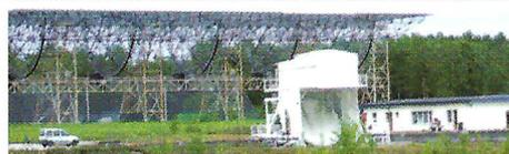
Le rayonnement réfléchi est envoyé sur un réflecteur en forme de calotte sphérique de 300 m de longueur et 35 m de hauteur. Cette charpente a une masse de 750 tonnes et sa forme ne s'écarte pas de plus de 5 mm de celle d'une sphère de 560 m de rayon.
