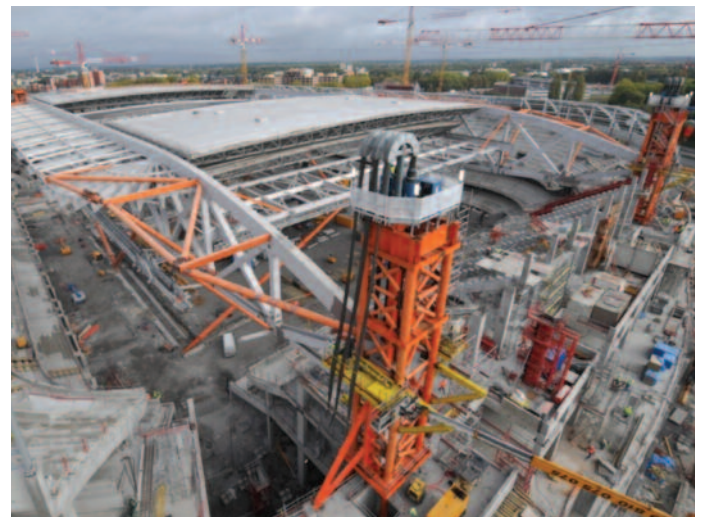
Figure 12 Levage de la toiture (©G. Tordjman & M. Lerouge)
