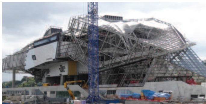
Figure 6 . Phase de construction (©J.P. Muzéau)
