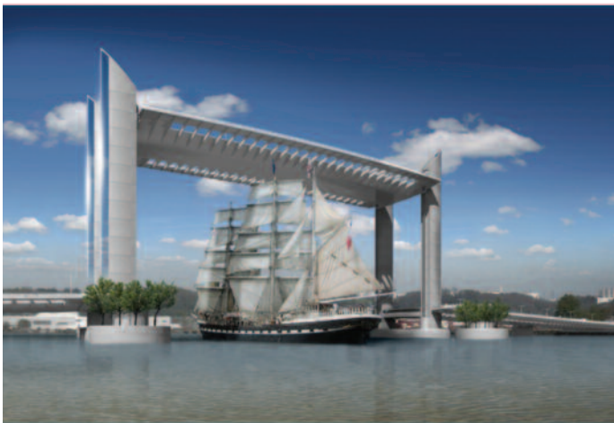
Figure 19 Le pont en position haute (©C.J. Rouaux)
