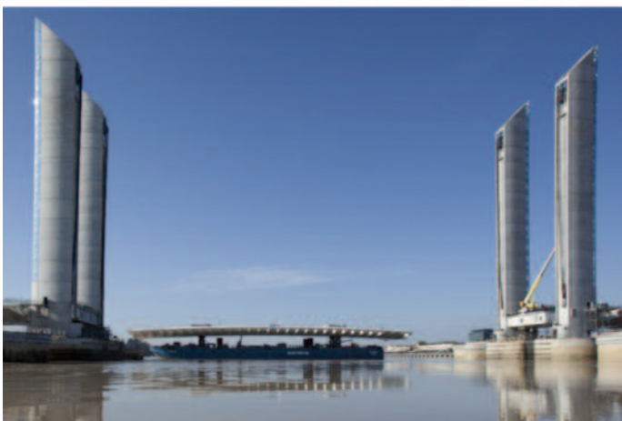
Figure 20 Installation de la travée centrale (©Cimolaï)
