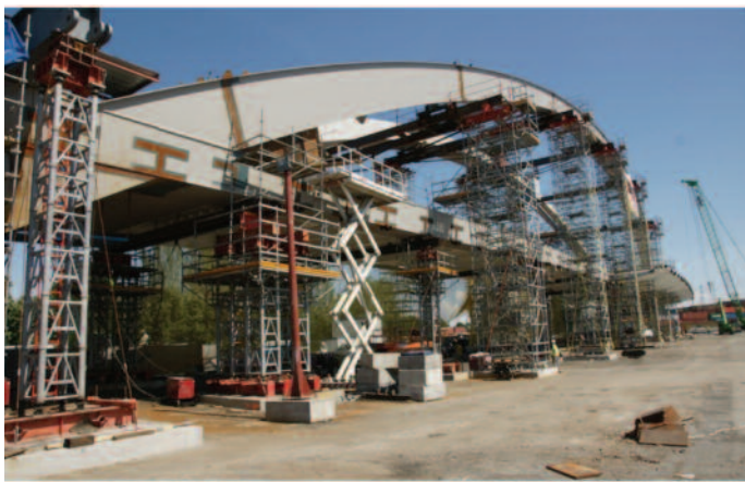
Figure 22 Phase de construction (©C. Cheron, C. Lavigne & T. Lavigne)
