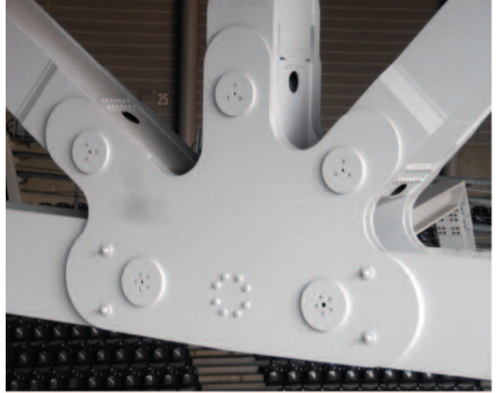
Figure 11 Nœud de la membrure inférieure (©J.P. Muzeau)
