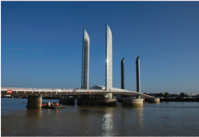
Figure 18 Ouvrage en position basse (©ConstruirAcier)
