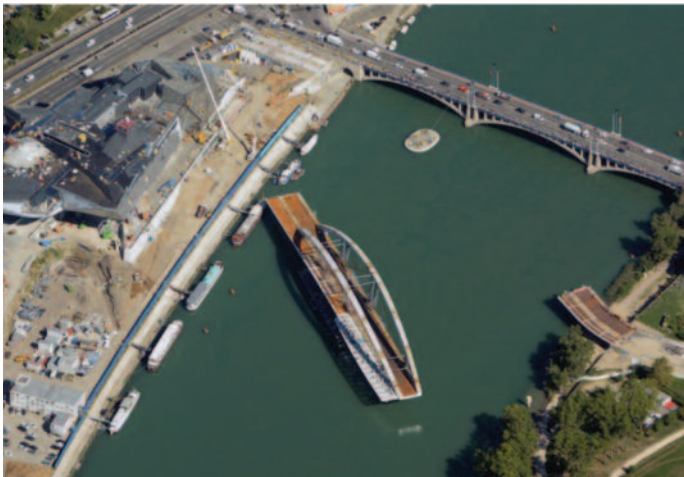
Figure 23 Transport de l'ouvrage (©Spielmann)
