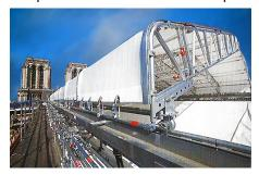
tégées avaient provoqué des infiltrations. Ce n'est que depuis août 2021 que la mise hors d'eau totale des parties hautes de l'édifice est assurée avec la pose d'un parapluie coulissant sur la nef, le chœur et la croisée et de bacs aciers sur le transept.
