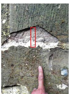
Sur un des murs où apparaissait la couleur verdâtre il a été prélevé un échantillon de 1 cm d'épaisseur environ (zone de prélèvement). La coupe, en épaisseur, montre :
