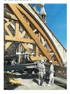
Ne pas oublier que ces arcs sont à la base de la résistance des constructions gothiques qui se caractérisent par des murs fins et hauts.
