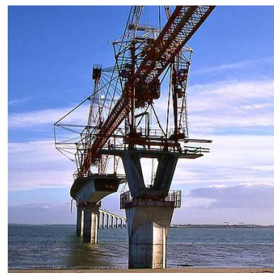
Figure 31 - Poutre de lancement pour la construction du Pont de l'île de Ré [APC 2015]
