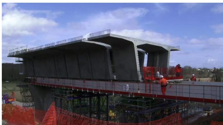
Figure 25 - Assemblage de voussoirs préfabriqués sur cintre [LGV 2015]
